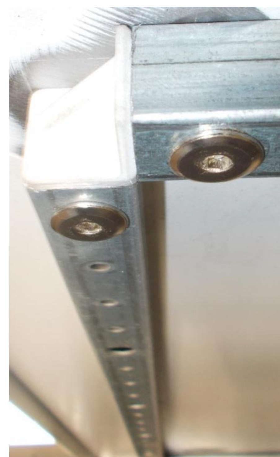
Дверь «Провенто» с замкнутыми усилителем и новыми соединителями
