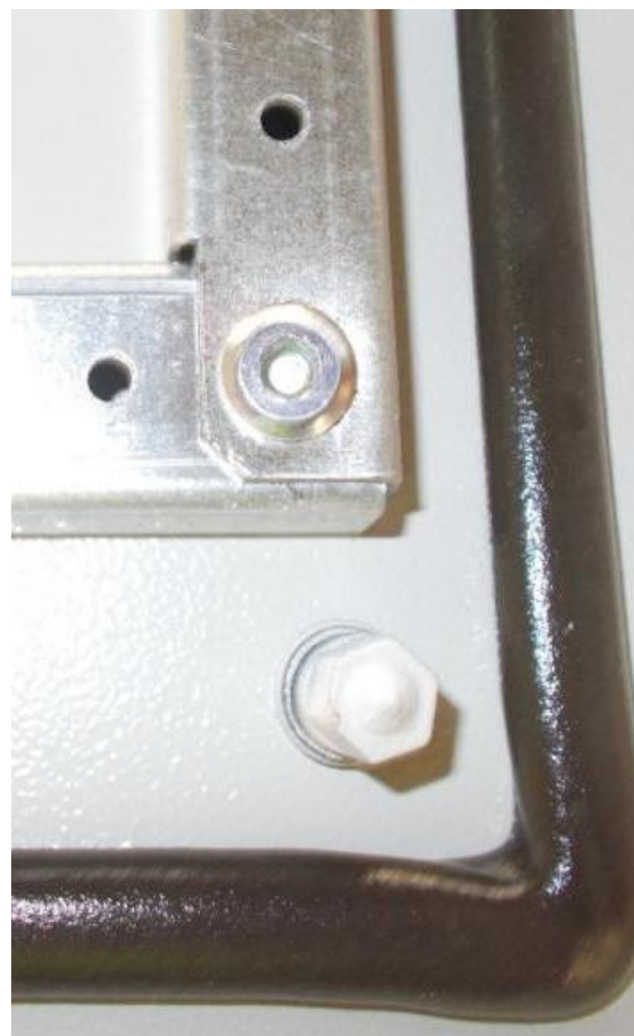
Дверь «Провенто» с незамкнутым усилителем
