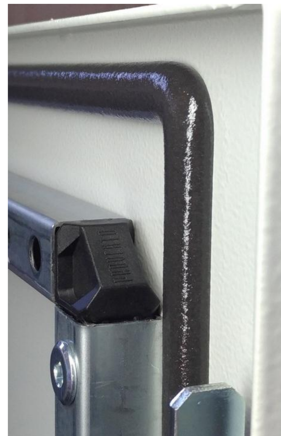
Дверь «Провенто» с замкнутыми усилителем и новыми соединителями
