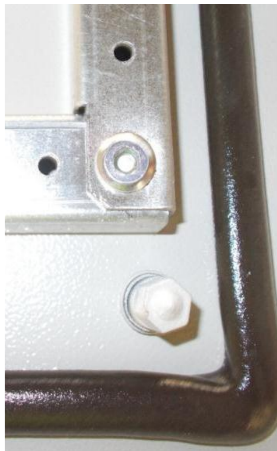
Дверь «Провенто» с незамкнутым усилителем
