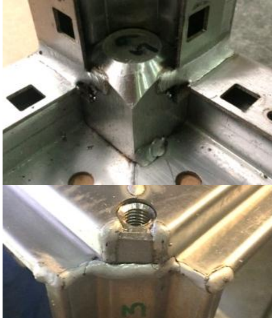
Сварные швы рамы, сваренной импульсным режимом в новом защитном газе
